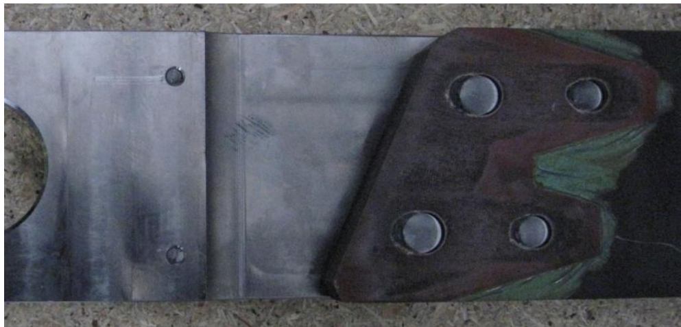
б) разрушение всех болтов по срезу шестигранных головок
