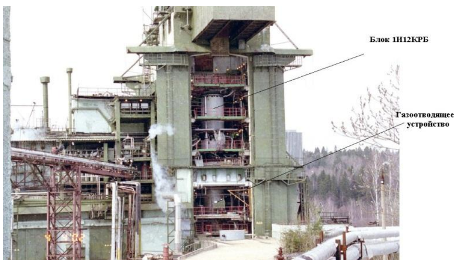
Рис. 1.6. Испытание ДУ на стенде
