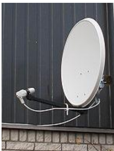
Рис.2. Офсетная антенна
