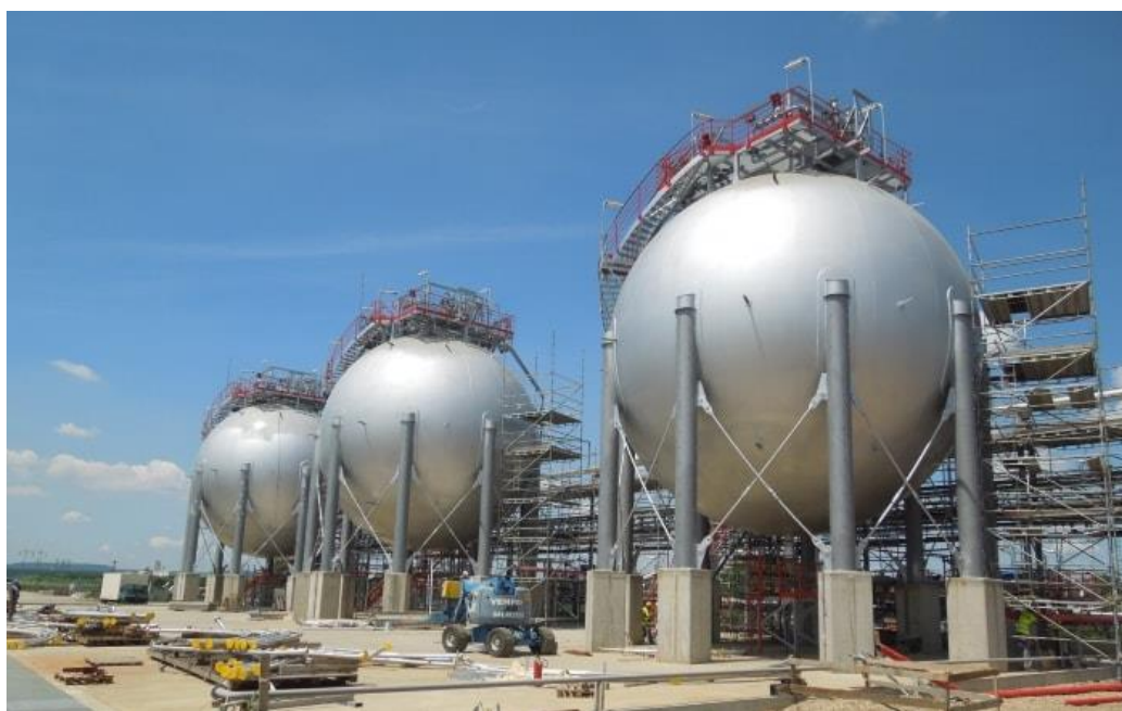
Рис. В.1. Сферические резервуары
