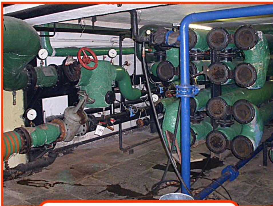
ЦТП до реконструкции
