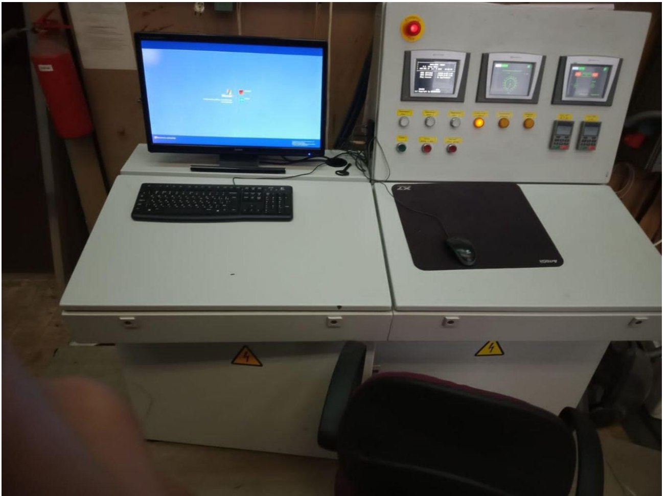
Рисунок 5.7-Пульт автоматического управления испытательным оборудованием стенда
