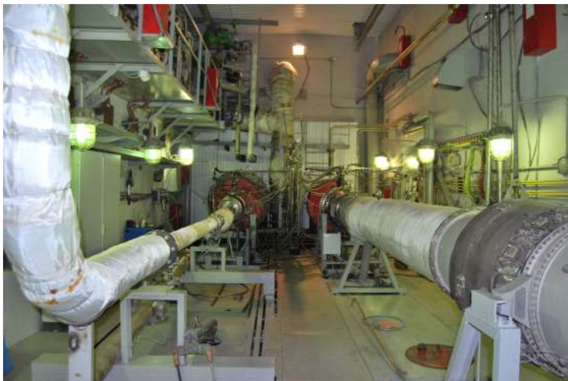
Рисунок 6.38 – Общий вид рабочего бокса 27 с линиями для испытаний пятигорелочного отсека (слева) и полноразмерной камеры сгорания авиационного газотурбинного двигателя ПД-14 (справа)
