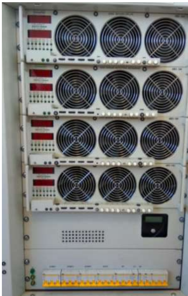
Рисунок 16. Источники питания магнетронов установки МРМ-1
